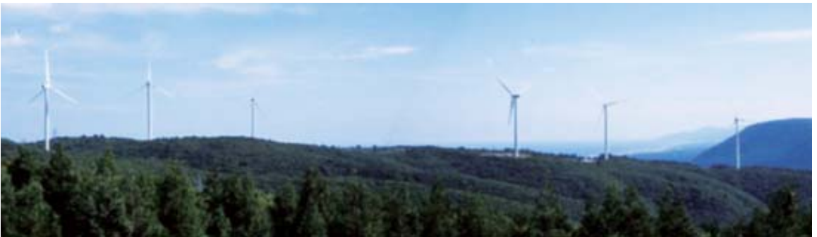
青森県東通町の陸上風力発電 (2,000kW×6基)
