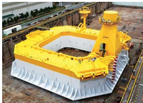
北九州沖合の洋上風力発電システムの浮体構造物
