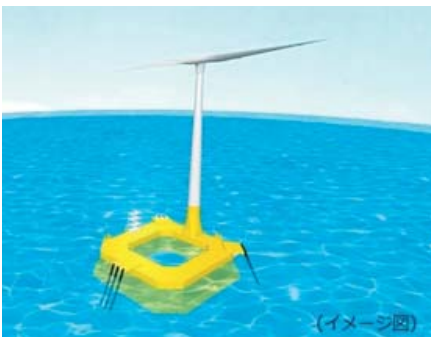
浮体構造物の設置イメージ
