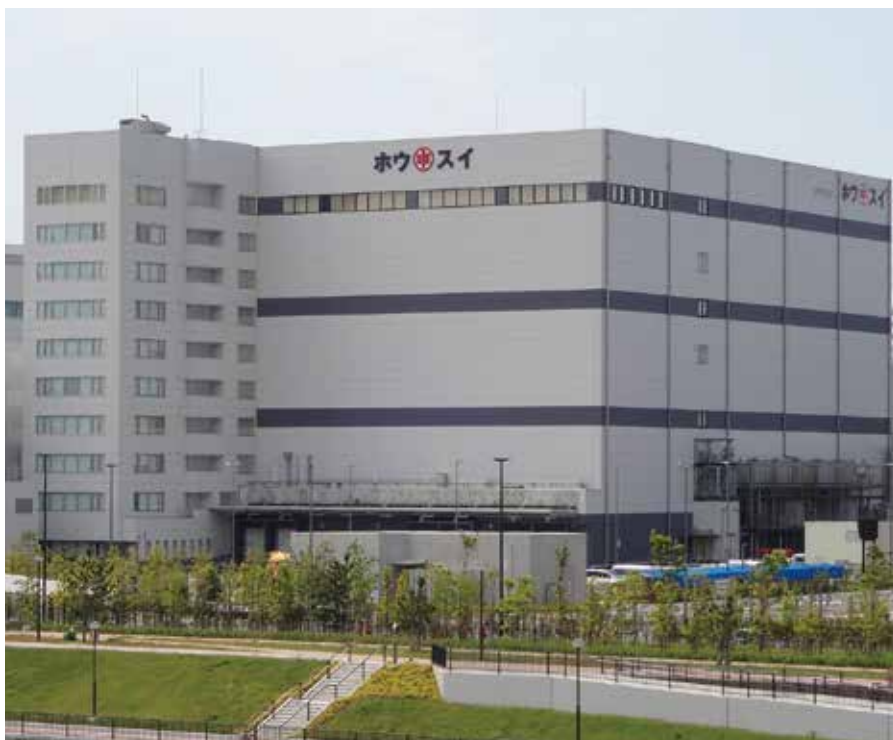
本社・豊洲冷蔵庫
