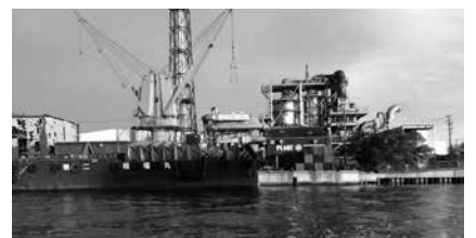
港湾に面した工場
