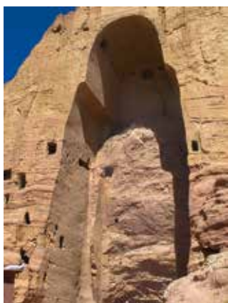
タリバンによって破壊されたバミヤーン遺跡
