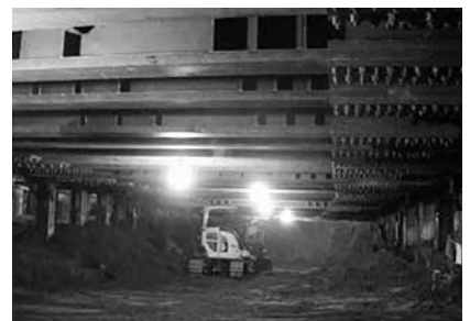
地下は工事(アンダーピニング工法)
