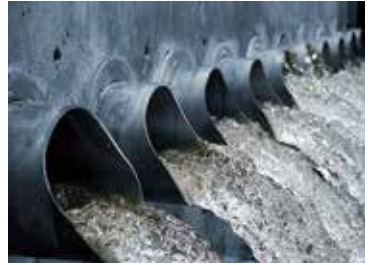
普段は目にする事のない インフラ施設の代表「下水道」
