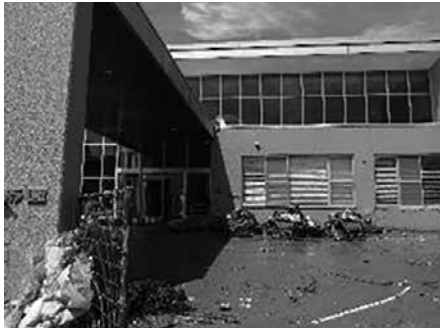
球磨川のはん濫で被災した老人ホーム
