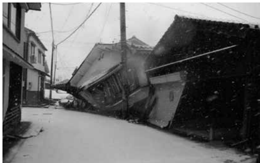
2階建て木造住宅倒壊(穴水)
