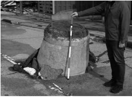
マンホールの浮き上がり（輪島）
