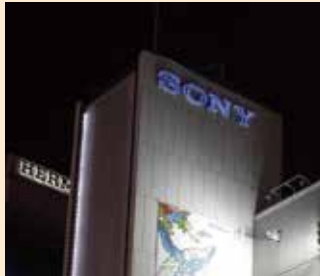
数寄屋橋ソニービル
