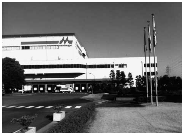
森永乳業東京多摩工場
