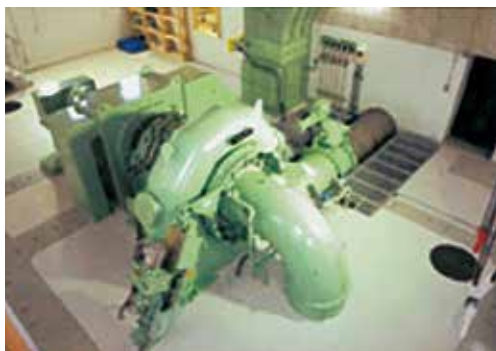
水車の回転により発電する
